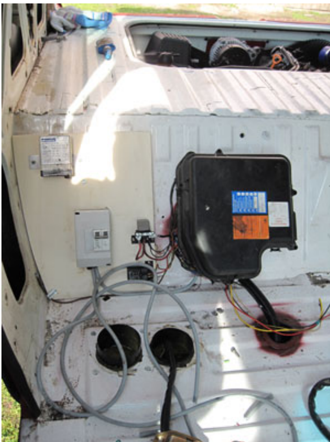
Standheizung Eberspächer D2L schon eingebaut, da Tank noch leer war...
